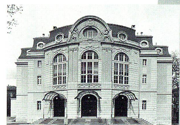
Eingangs-Fassade (Foto: R. G. Stichnothe, Städt. Hochbauamt)
