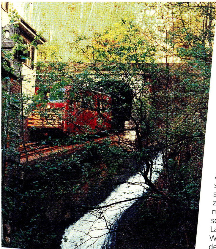
Der elektrische Zahnradtriebwagen bei der Einfahrt in den Tunnel 2 Tage vor Einstellung des Betriebs!
