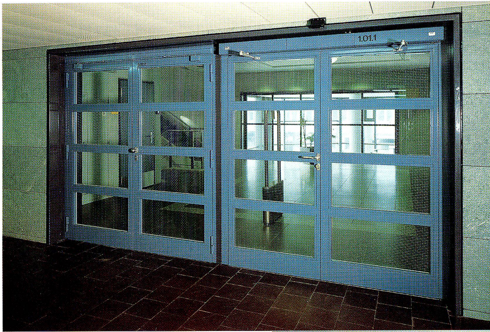
Brandschutztüre mit Elektroantrieb ▲
