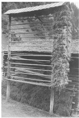
Die Abbildungen 15 und 16 zeigen zwei einfache, freistehende Kornhisten, die jeweils an einem Heugaden befestigt sind, links giebelseitig, rechts traufseitig. Die zwei bis vier angebrachten Greifarme werden 'Hunde', tgauns, genannt. Der Name soll von der fratzenförmigen Ausbuchtung des Strebenendes herstammen, das in eine der Histlatten eingreift und das Gerüst festhält.
