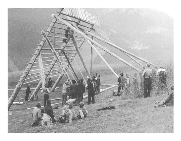
Hier lassen sich die verschiedenen Arbeitsgruppen gut unterscheiden. Auch die vierte Strebe wird nun von einem Mann im Gebälk eingehängt. Etwa 15 Bauern sichern und stossen in der Mitte des Bildes. Eine vierte Gruppe bilden die fünf Buben, die verwundert zusehen, wie die Erwachsenen sich abmühen! Vom Einbau der gegenseitigen Streben ist noch kein Anzeichen vorhanden. Die Gefahr des Überkippens bei der Erreichung des Kulminationspunktes besteht noch nicht.
