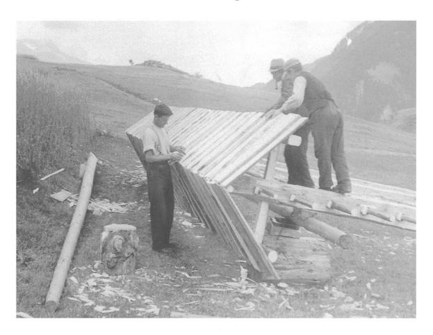
Der auf der Erde abgestützte Dachflügel ist fertig erstellt. Drei Arbeiter richten und verteilen die Brettchen der Dachschichtreihe. Dann folgt die Vernagelung. Die Dachkonstruktion ist gut durchdacht: an dem durch den Histpfosten gezogenen Querarm sind die zwei Längslatten befestigt. Daran sowie an der gut sichtbaren Firstlatte können die Brettchen vernagelt werden.
