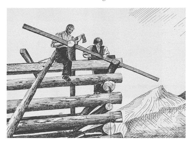
In Darpagaus, zwischen Rueun und Pigniu. – Zwei Zimmerleute im Dachgebälk. Die erste Pfette, il pardaun, wird gesetzt. Mit einem Richtscheit wird die Neigung des Dachflügels, la pendenza dil tetg, bestimmt. Der weitere Aufbau des Dachstockes ergibt sich von selbst. Die zwei oben arbeitenden Zimmerleute werden auch weiterhin von den vielen mithelfenden Bauern unterstützt.
