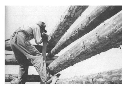
Für das neu gehobene Rundholz wird der genaue Gewettaushub eingezeichnet. Dazu verwendet der Zimmermann die Setzlatte.
