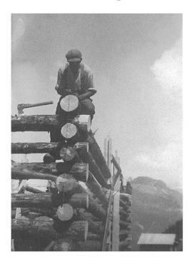
Der Zimmermann hat die Rundholz-Gewettausbuchtung mit dem Beil ausgehoben und das neue Holz aufgesetzt. Es muss mit den unteren Köpfen genau im Senkel stehen.
