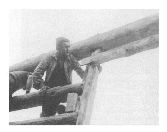
Eine der vielen Einzelleistungen innerhalb der Mannschaft. Ein Mann ausserhalb des Baugedränges: es ist Felix, der Sohn des Bauherrn. Der «Obertürnerbalken» ist an Ort und Stelle gebracht worden. Er muss noch mit seinen Lochungen in die Zapfen (pelis) der Torpfosten einsenken. Der Mann versucht, den Pfosten in die richtige Stellung zu rücken. Hinter ihm buckelt und hält ein zweiter Mann den Balken.
