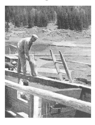
Nr. 4: Acla im Medelsertal. – Der Zimmermann mit der Wandbalkenhaue. Sie besteht aus einem etwa 1 m langen Restsparren mit einem schräg eingelassenen Stiel. (Foto: A. Maissen)
