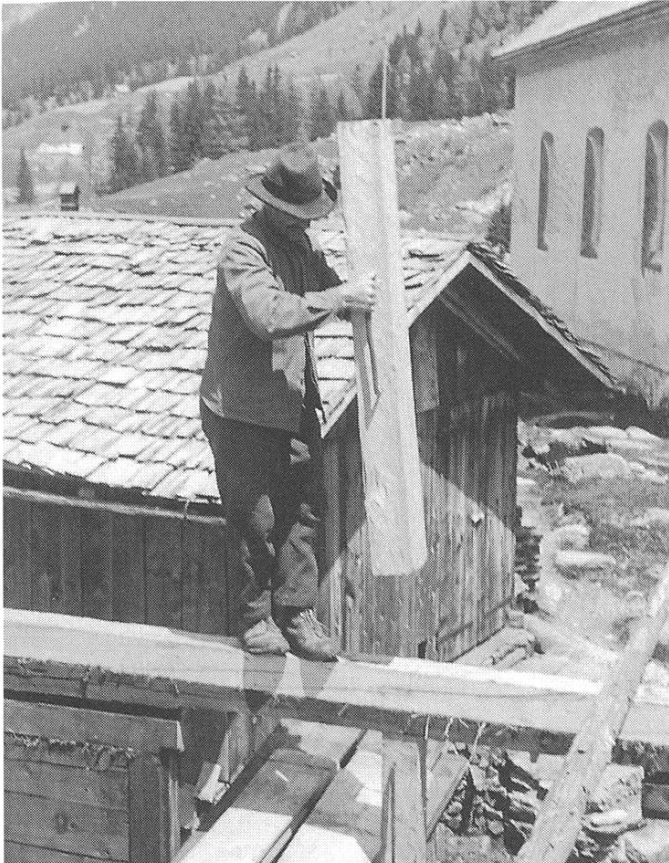
Nr. 5: Acla . – Ein zweiter Rammer mit einem anders geformten Sparren. (Foto: A. Maissen)
