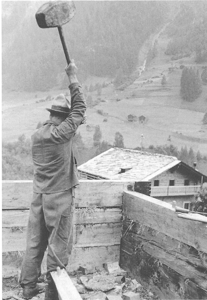
Nr. 9: Evolène . – Ein zweiter Zimmermann versetzt Schläge mit seiner Balkenkeule. Diesmal vom festen inneren Fussboden aus. Das Gewett ist noch nicht ganz ineinander, 1943. (Foto: A. Maissen)
