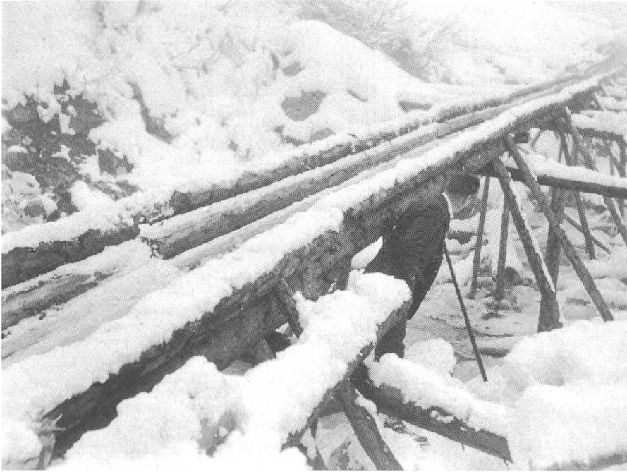
Künstliches Holzgeleit ( eral da lain ) im Val Sampuoir. Winter 1925/1926 – Ungefähr 1 km lang. Beförderte zirka 3000 fm Holz. Es handelt sich um eines der letzten dermassen ausgebauten Holzgeleites.
