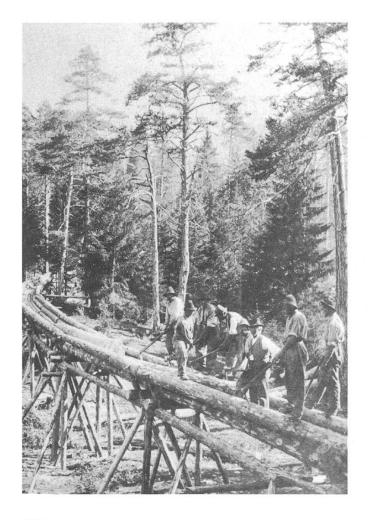
Ein Teilstück des Holzgeleits im Val d'Assa. Der Bau ist leicht gebogen, jedoch ohne scharfe Kurven. Waldarbeiter (burolers) arbeiten mit ihren eingehackten Zapinen in einem Holzblock.
