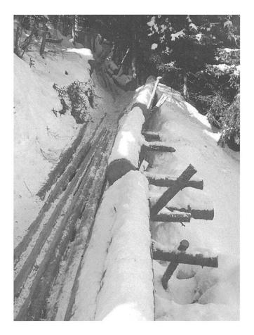
Laneras, Wald zwischen Ladir und Falera, 1941. Der einfache Bau besteht aus einem Lattenboden. Die Aussenseitenwände werden durch dicke Baumstämme gebildet. Sie werden durch Kreuzpfähle gestützt.
