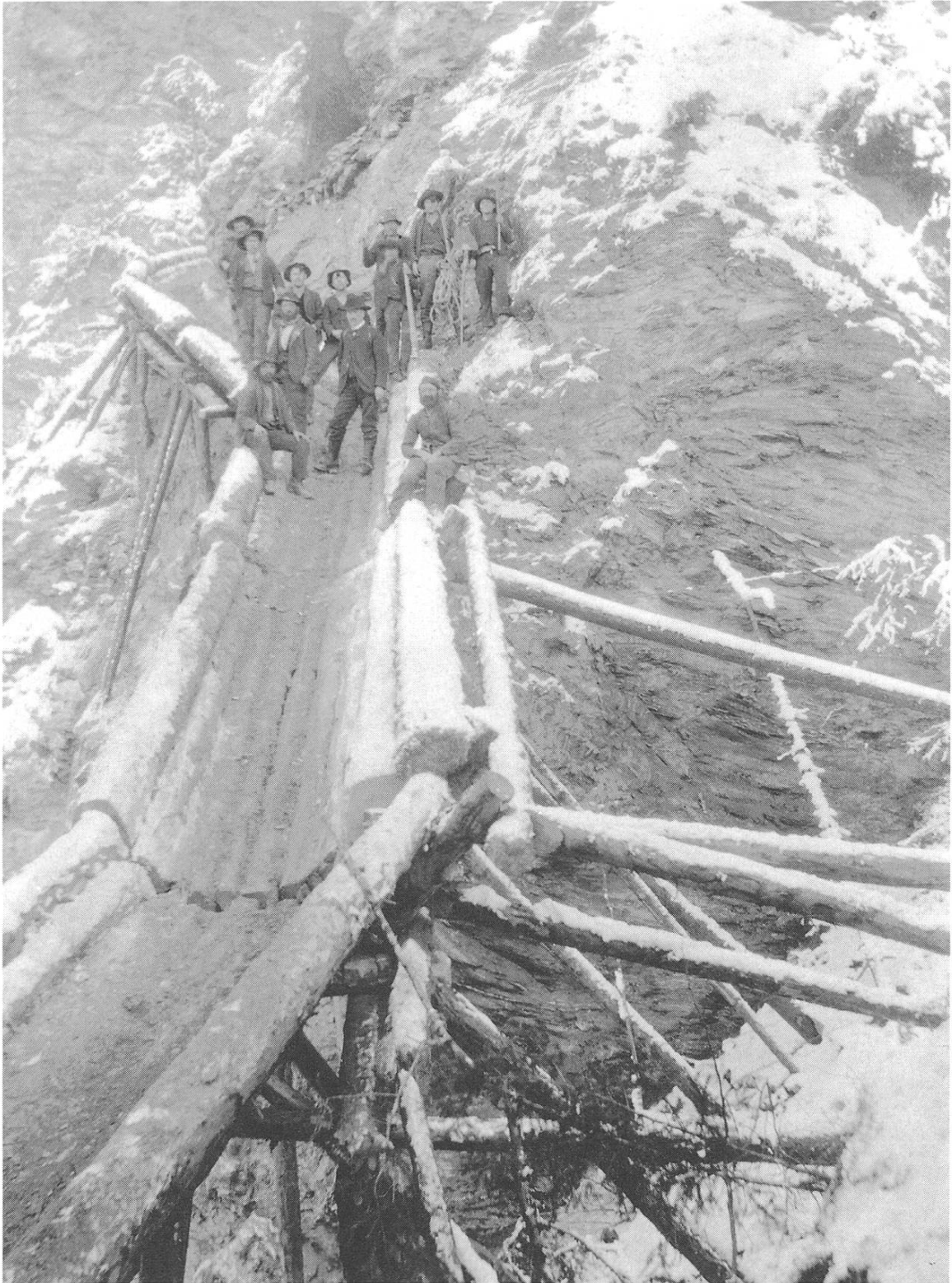
Palisadenries im Val Sampuoir . Es ist das letzte Teilstück eines mächtigen Geleits vor der Ausmündung. Die etwa 5 m langen Geleitlagen bestehen aus mindestens 8 Boden- und Bandenhölzern. Waldarbeiter, Vorsteher und Kurvenwachen ( ils postigliers ) mit ihren Zapinen im Hintergrund.
