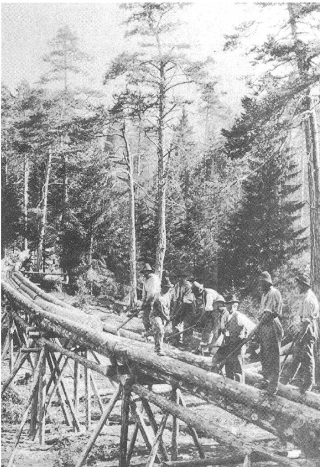
Ein Teilstück des Holzgeleits im Val d'Assa . Der Bau ist leicht gebogen, jedoch ohne scharfe Kurven. Waldarbeiter ( burolers ) arbeiten mit ihren eingehackten Zapfen in einem Holzblock.
