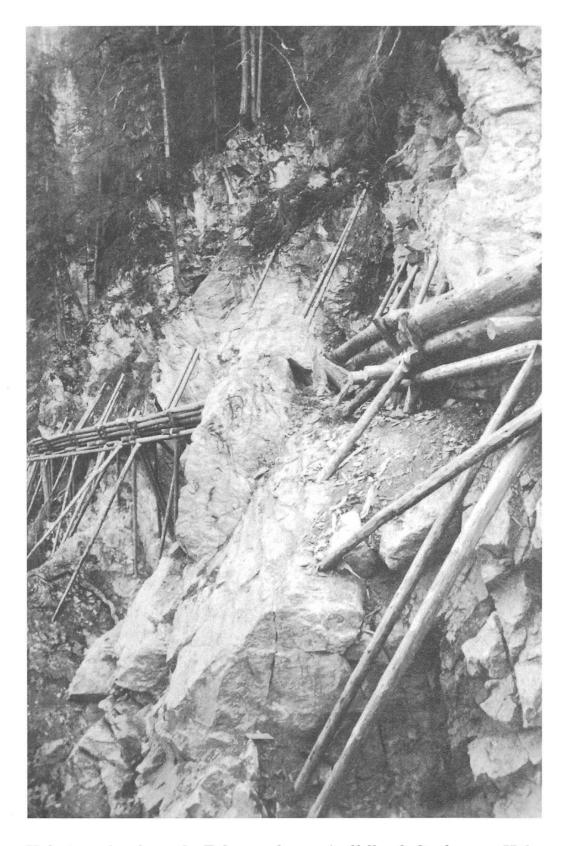
Holzriese durch steile Felsen gebaut. Auffallend die langen Holzstützen (guilas: Nadeln). Mit dieser kühnen Holzrutsche wurden 1886–1888 14000 Ster Brennholz für die Salinen in Hall, Tirol, transportiert.
