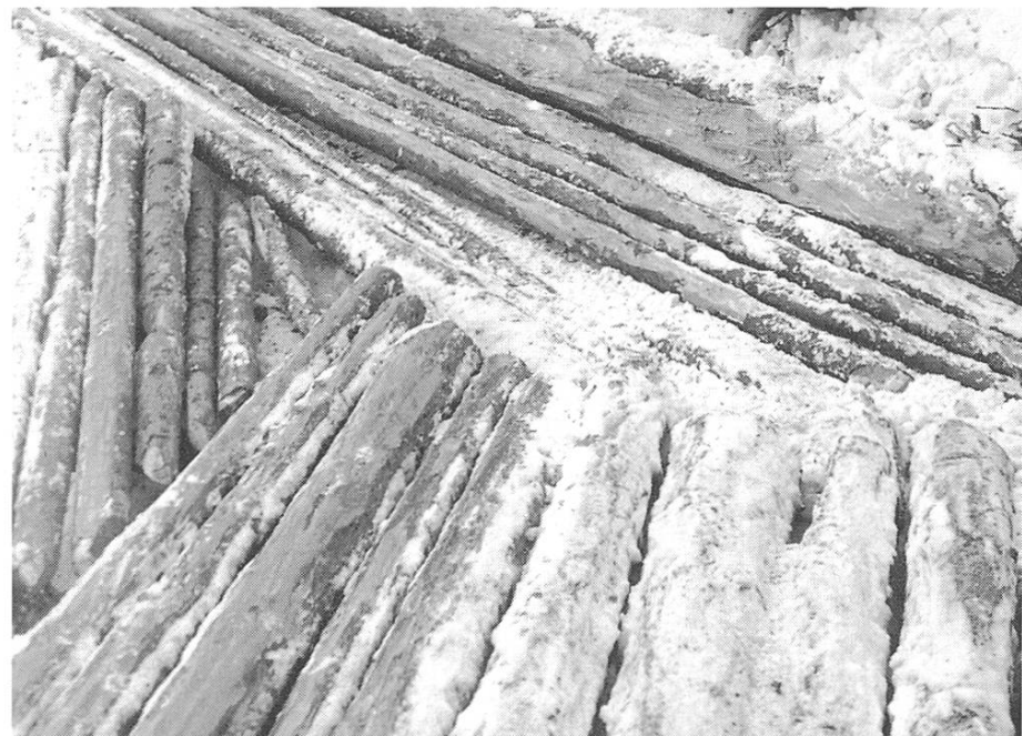
Laneras 1943. Der Geleitboden in einer scharfen Kurve. Er besteht aus mehr als 25 Latten, meist aus abgeschnittenen Tannenwipfeln bestehend. (Foto: A. Maissen)
