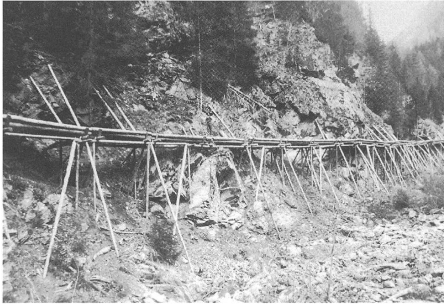
Holzgeleit im Val d'Assa , östlich von Ramosch gelegen. 1886 gebaut durch die Firma Casty-Pinösch . Bemerkenswert sind die zahlreichen Stützen aus abgeschnittenen Tannenwipfeln ( cheuas, guilas ).
