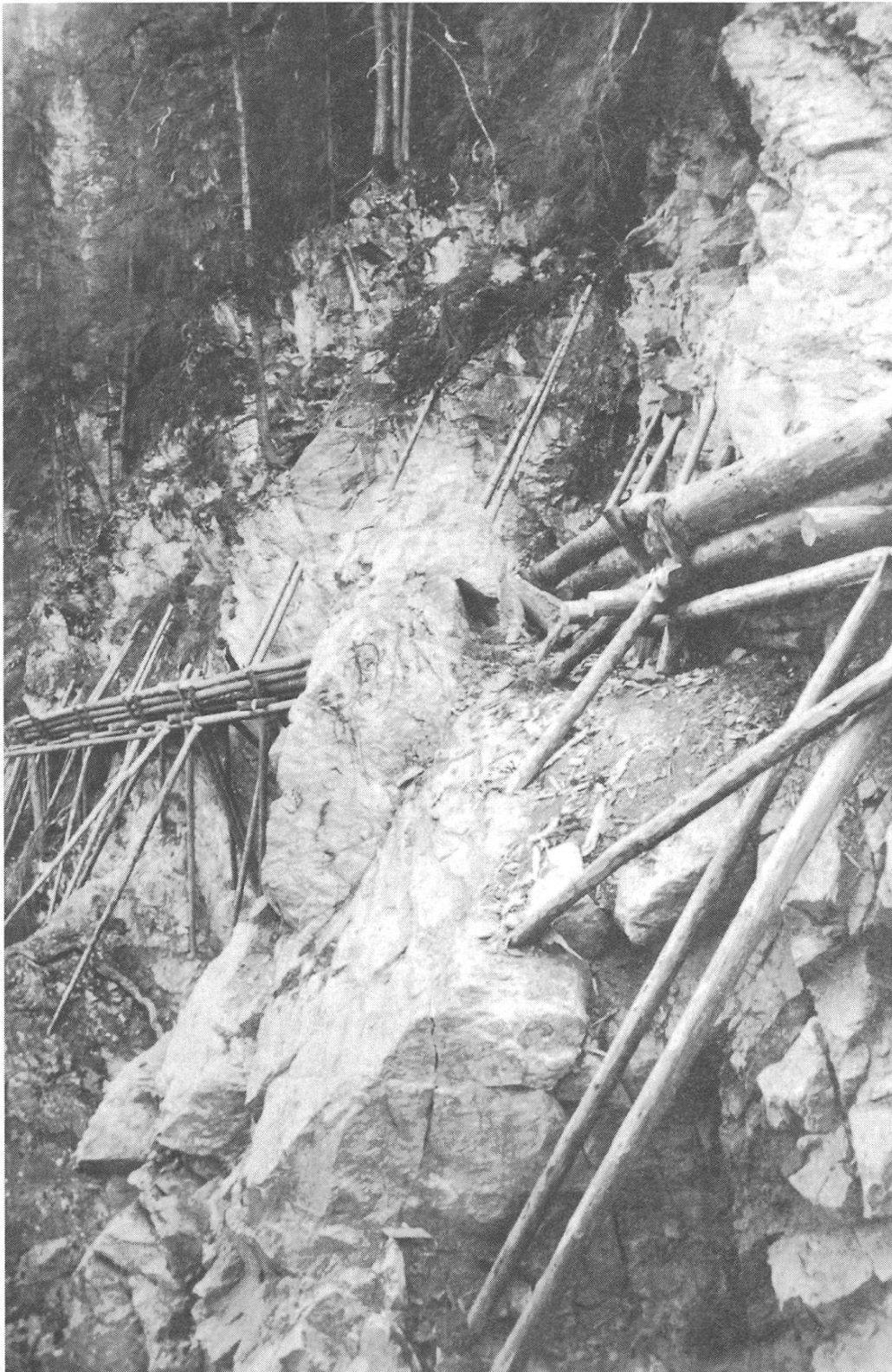
Holzriese durch steile Felsen gebaut. Auffallend die langen Holzstützen ( guilas : Nadeln). Mit dieser kühnen Holzrutsche wurden 1886–1888 14000 Ster Brennholz für die Salinen in Hall, Tirol, transportiert.
