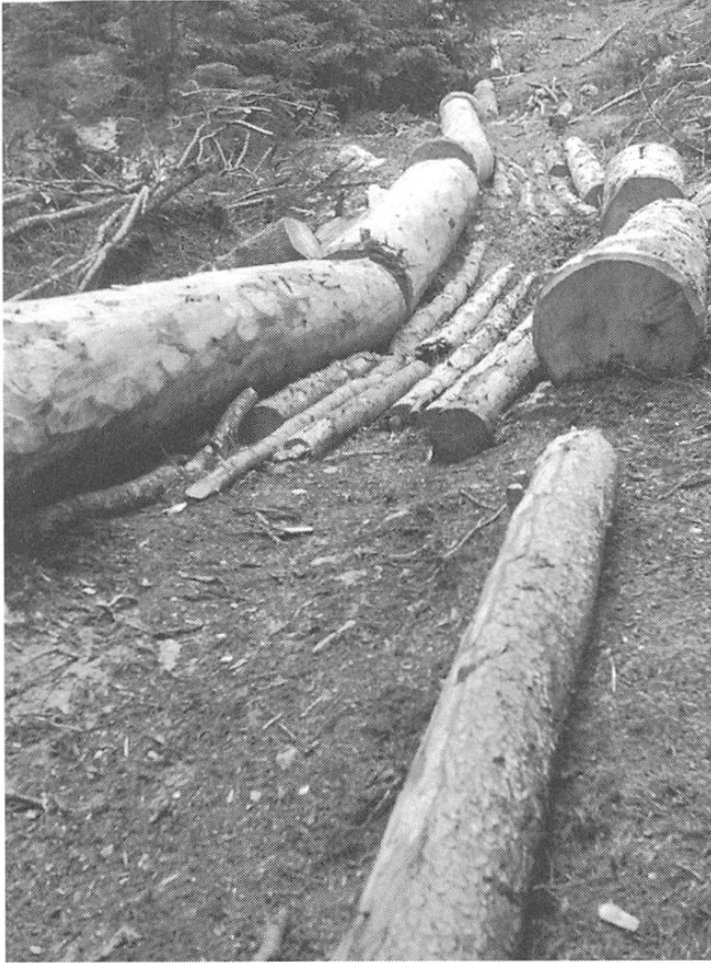
Ein Trocken-Holzgeleit ( schuenda, iral schetg ), um die Stammhölzer des Wald- randes am Calanda , 1943, bis zum Endlager zu beför- dern. (Foto: A. Maissen)
