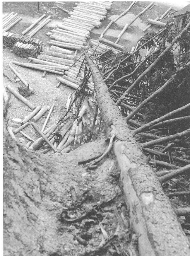
Auslauf des Erdgeleits am Calanda . Die urchige Tanne dient als Leitplanke. Von die- ser Auswurfstelle fliegen die Hölzer in die Tiefe bis zum Lagerplatz, wo sie zu Rollen geschichtet werden, 1943. (Foto: A. Maissen)
