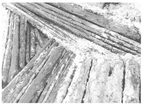
Laneras 1943. Der Geleitboden in einer scharfen Kurve. Er besteht aus mehr als 25 Latten, meist aus abgeschnittenen Tannenwipfeln bestehend.
