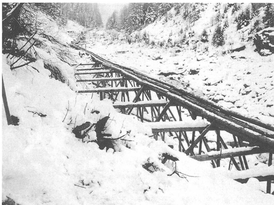
Holzgeleit im Val Sampuoir 1925/1926. Gut sichtbar ist der Holzkanal, ferner die Streben gegen den Hang, die vielen Stützpfähle.
