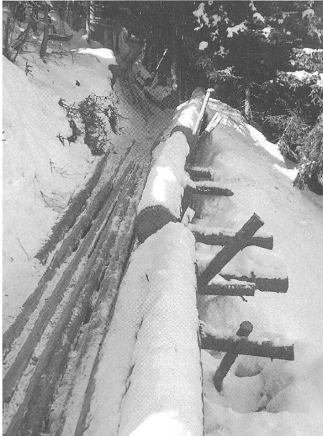
Laneras , Wald zwischen Ladir und Falera, 1941. Der einfache Bau besteht aus einem Lattenboden. Die Aussenseitenwände werden durch dicke Baumstämme gebildet. Sie werden durch Kreuzpfähle gestützt. (Foto: A. Maissen)
