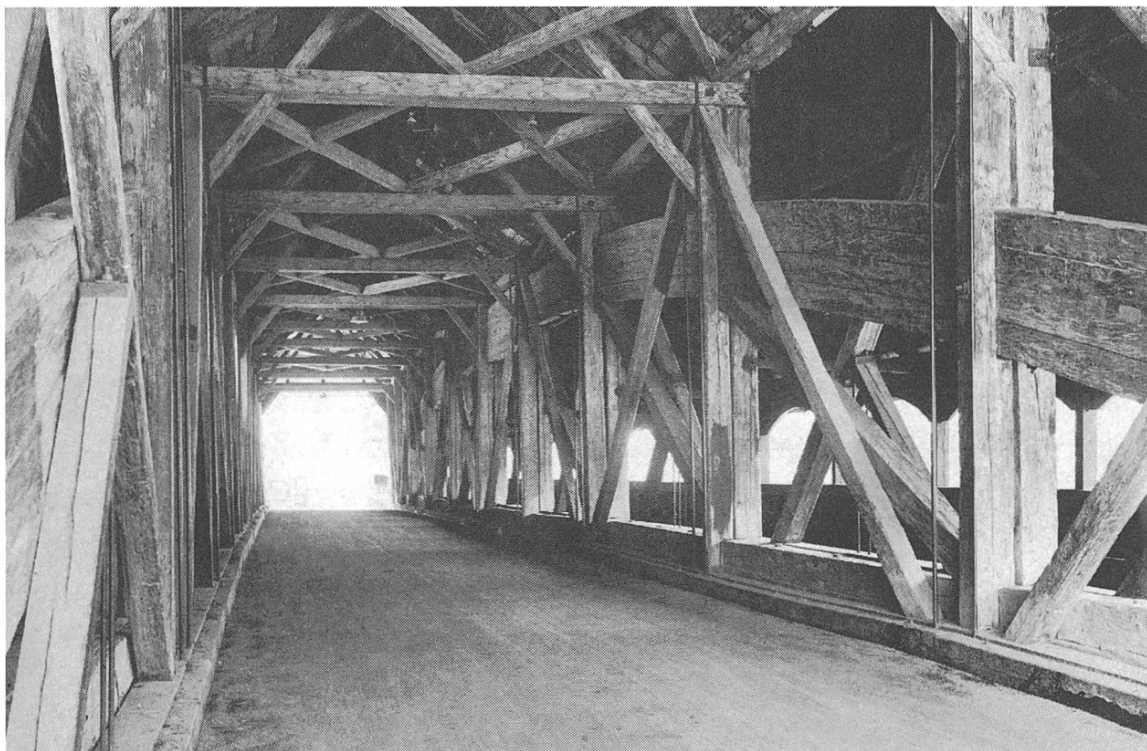
Die Innenkonstruktion des interessanten Bauwerks der hölzernen Rheinbrücke in Ilanz, erbaut 1850/51. Sie verband Ober- und Unter-Ilanz mit der dritten «Wurzelstelle» St. Nikolaus.
