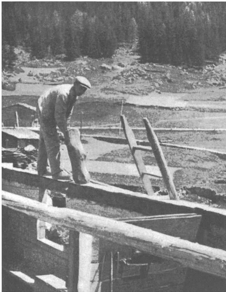
Acla (Val Medel) In lennari en preit. Cul grev mogn de preit stagna el giuaden la preit della casa. Avon che dar la frida schai il mogn sil schui dretg. Buccas, tgaus mugrin e darschuns ston ira inenglauter. (Foto: A. Maissen)
