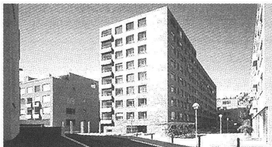
KraftWerk1, Zürich, Kreis 5, 2001, Stücheli Architekten, Zürich.
