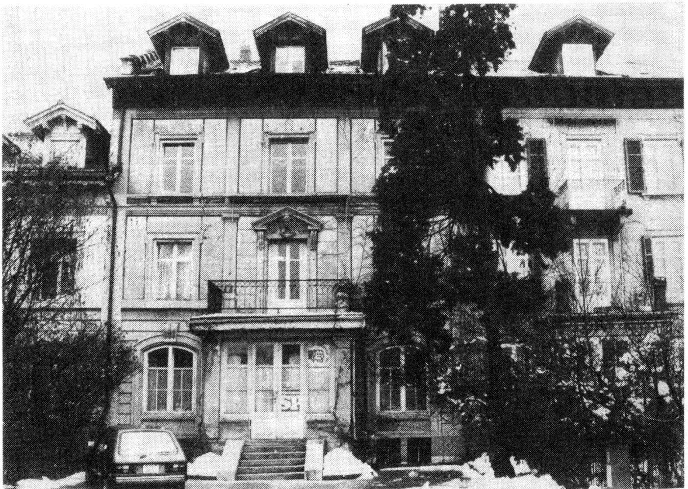
Die Südfassade der Liegenschaft Pavillonweg 3 (an der Stadtbachstrasse gegen die SBB-Geleise hin): Sandstein im Jugendstil, romantisch, aber da und dort bereits am Bröckeln. Sanierungsbedürftig sind in erster Linie Balkon, Fassade, Keller und Dach. Der Baum vor dem Haus weiss, was Waldsterben ist.
