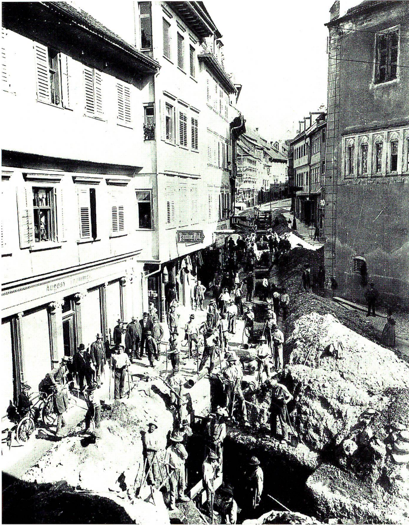
Der Bau der Kanalisation in Ravensburg um 1900
