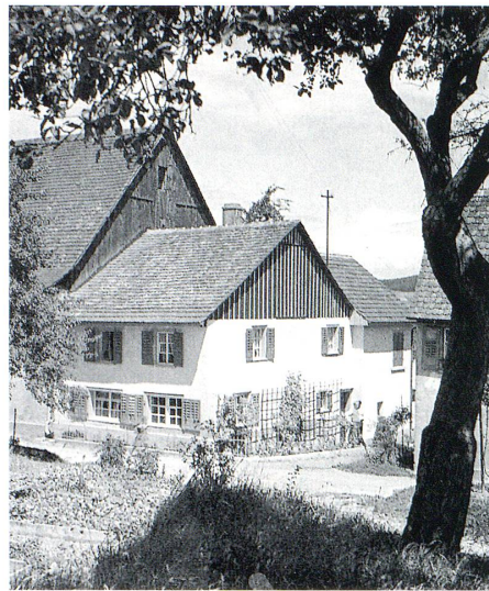
Wohnhaus Dittrich um 1939.
