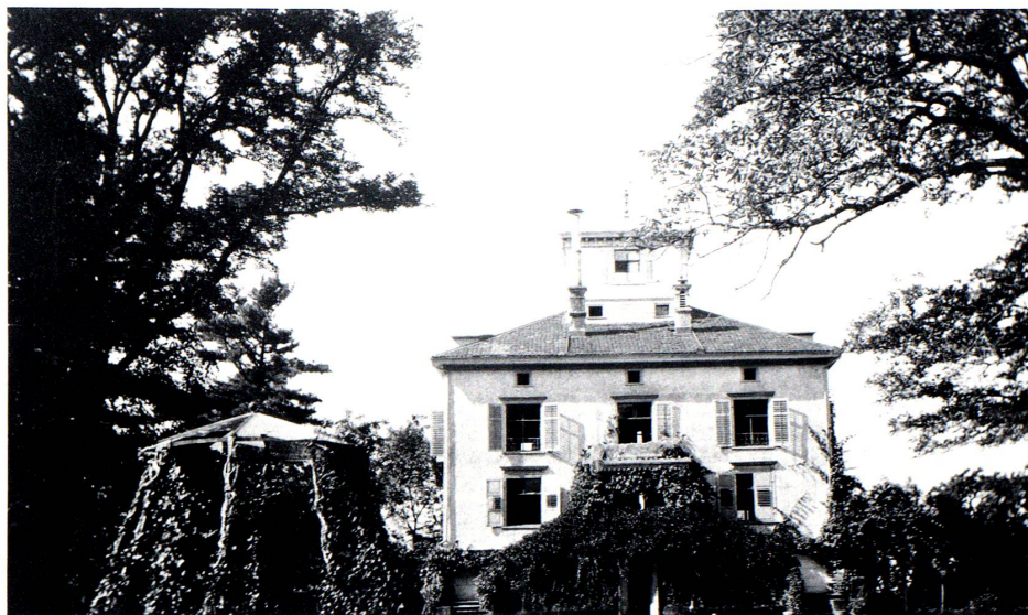
Villa Mariahalde vor dem Umbau von 1917. Ansicht von Süden (Parkseite). Photographie. Photoarchiv des Verfassers.
