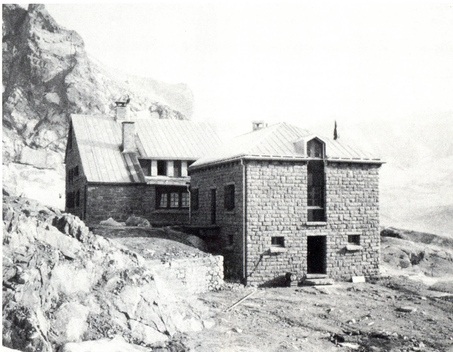
Alt- und Neubau der Forno-Hütte fügen sich organisch in die felsige Umgebung über dem Forno-Gletscher ein. Foto P. Hug.
