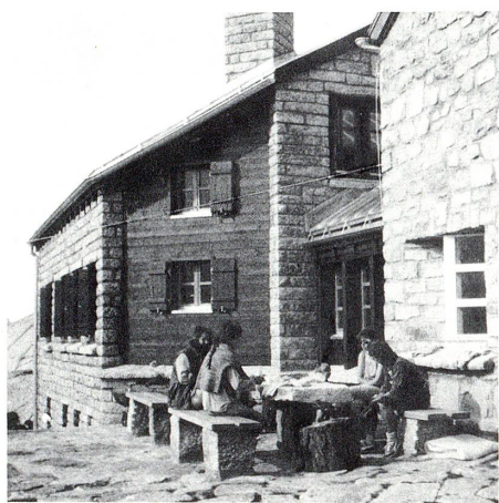
Der erweiterte Hüttenvorplatz, im Hintergrund der neue Erweiterungsbau, der durch einen Zwischentrakt mit der Haupthütte verbunden wurde. Foto P. Hug.
