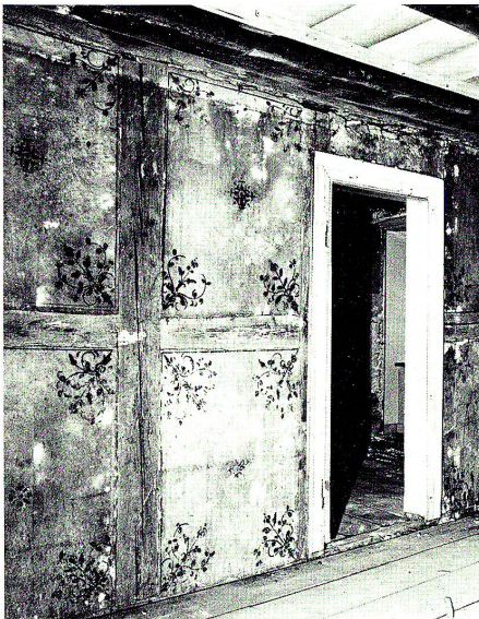
Rapperswil, Fischmarktstrasse 14. Fachwerkwand mit dekorativer Malerei, A. 17. Jh. (zerstört).
