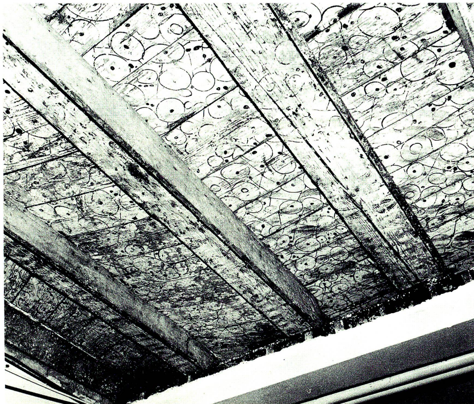
Thal, Marienburg. Balkendecke im Eingangsflur mit «Seifenblasen-Marmorierung», Zustand vor der Restaurierung.
