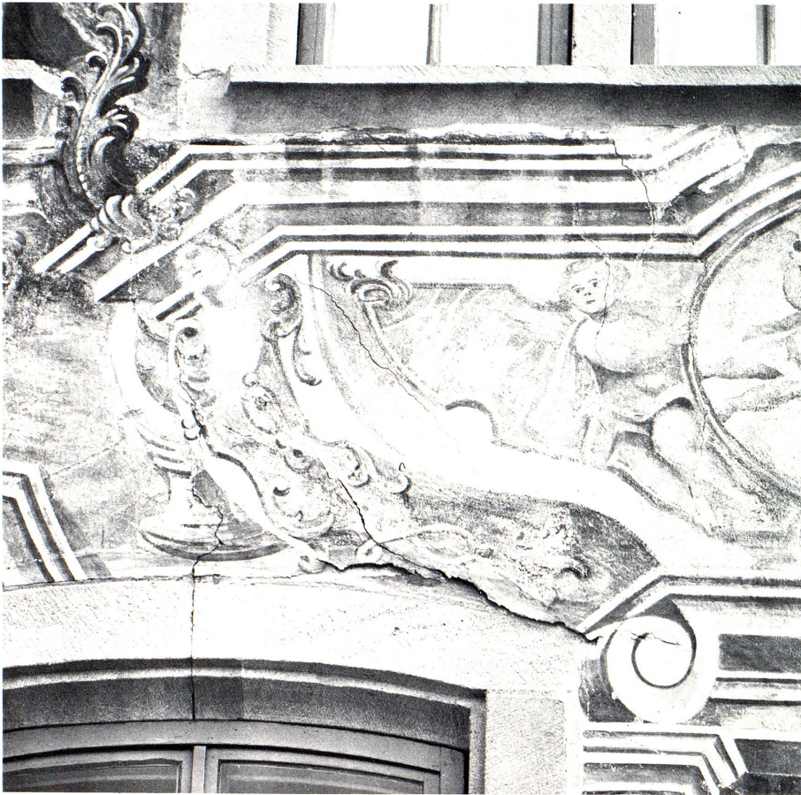
5 Zug, Brandenberghaus, Unterbau des Scheinerkers, Zustand 1976.
