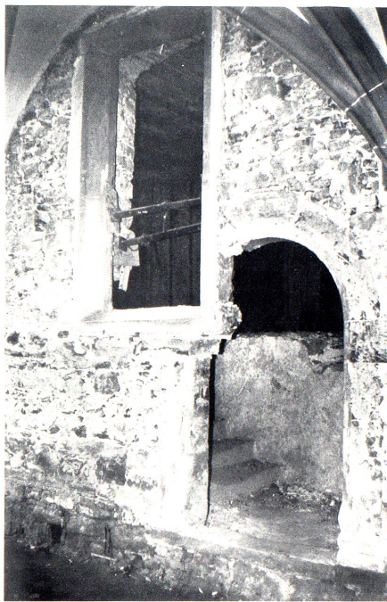
Bei der Entfernung des Mauerwerkes in der alten Türöffnung wurde dahinter der ehemalige Treppenaufgang zum Zwischengeschoss entdeckt. Hier zeigt sich deutlich die nachträgliche – sicher unerwünschte – Fenstervergrößerung vom Zwischengeschoss zum Kreuzgang.
