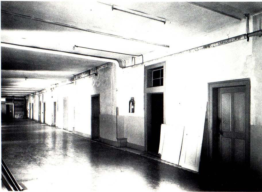
Korridorflucht im Zustand vor der Restauration.
