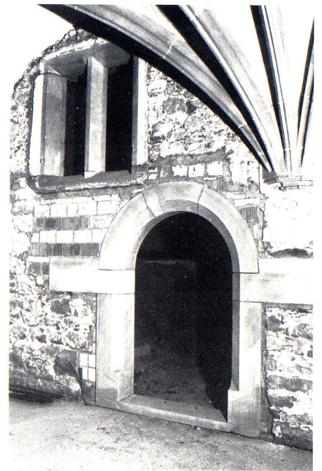
Die Ergänzung der vorgefundenen Bauteile zeigt überzeugend den Original-Zustand.
