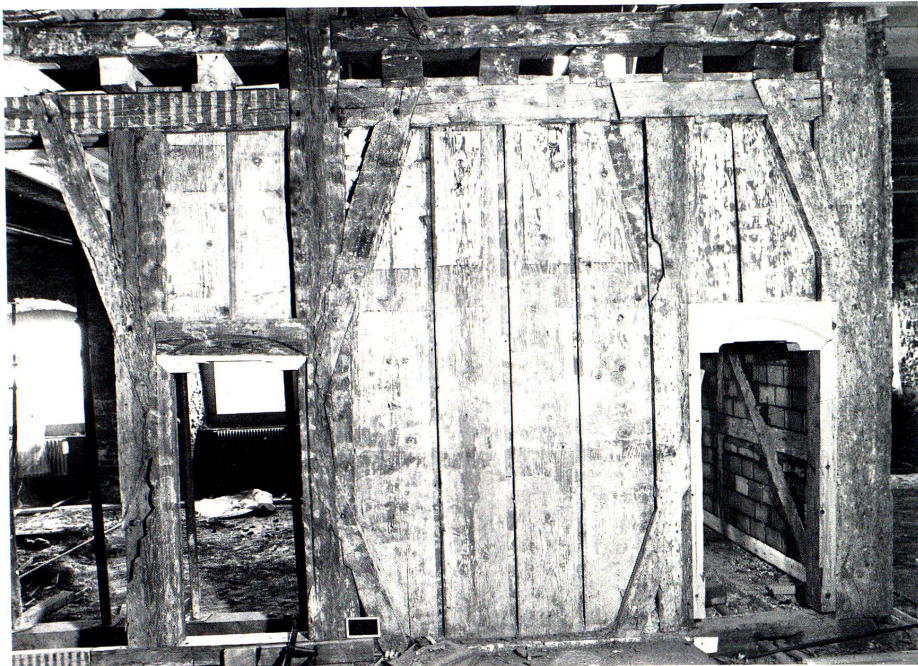
Die alte Bohlenwand im Nordflügel, Obergeschoss, mit teils aufgemalten «Holzkonstruktionen» wird im Originalzustand belassen.
