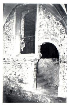
Bei der Entfernung des Mauerwerkes in der alten Türöffnung wurde dahinter der ehemalige Treppenaufgang zum Zwischengeschoss entdeckt. Hier zeigt sich deutlich die nachträgliche — sicher unerwünschte — Fenstervergrösserung vom Zwischengeschoss zum Kreuzgang.
