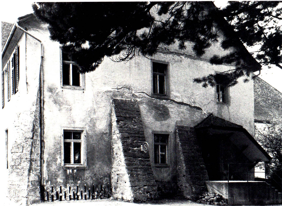
Der schwerfällige Hauseingang an der Ostseite war sicher eine Kreation des letzten Jahrhunderts.
