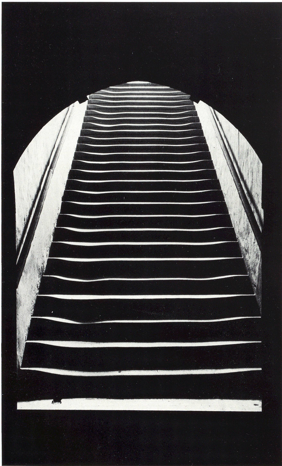
Der Treppenaufgang im Ostflügel zeigt noch die gleichmässig ausgelauenen, bald 500 Jahre alten Sandsteinstufen.
