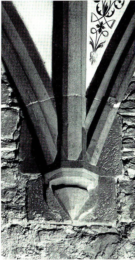
Überarbeiten schadhafter Partien der Rippenkonsolen.
