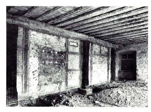
Freilegen der gotischen Holzbalkendecke und geschnitztem Mittelpfeiler der früher zweiachsigen Hallenräume im Obergeschoss Westflügel. Die Gangwand wurde im 19. Jahrhundert eingefügt.
