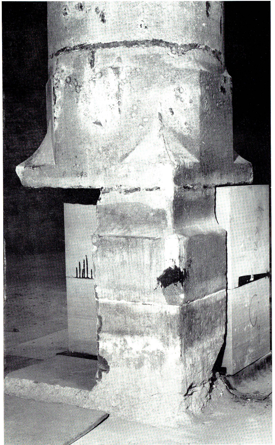
Die teils stark beschädigten Pfeilerbasen der Erdgeschoss-Säle mit ihren grossen Traglasten der Gewölbe und der oberen Stockwerke mussten sorgfältig quadrantweise durch neue Werkstücke ersetzt werden, die am Bau nachgehauen wurden. Dabei wurde den Isolationsmassnahmen gegen die werkzerstörende aufsteigende Feuchtigkeit grosse Beachtung geschenkt.
