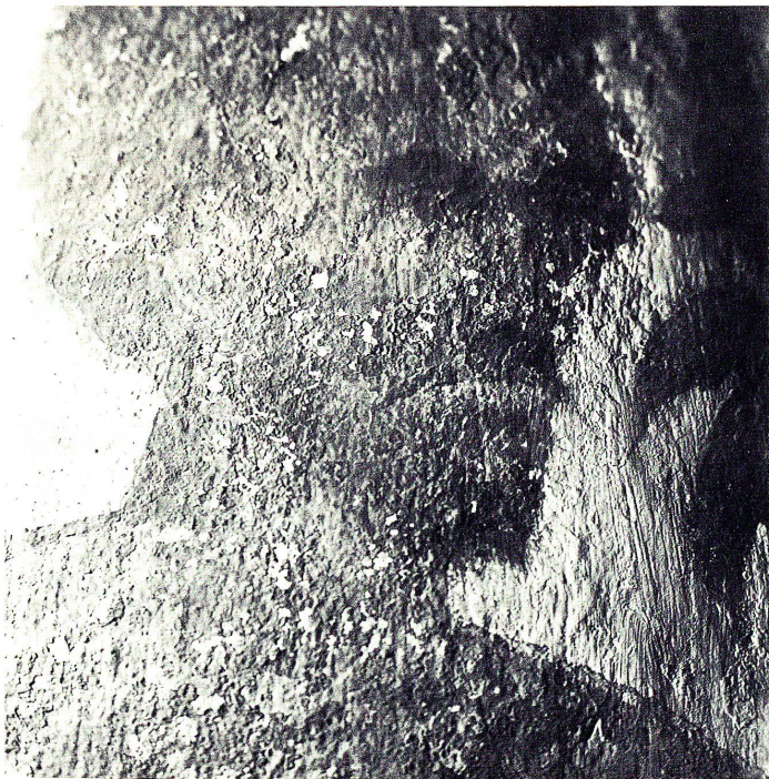
Kopf der Figur Adams (Feld 47). Streichspuren des Wandputzes, Spachtelkratzer, Farbabbblätterungen.
