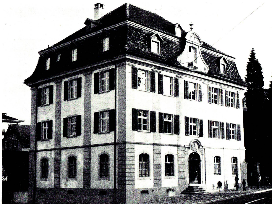
Unter Mithilfe der kantonalen Denkmalpflege wurde das Rorschacher Amtshaus an der Mariabergstrasse aussen und innen stilgerecht restauriert. Photo P. Hug.
