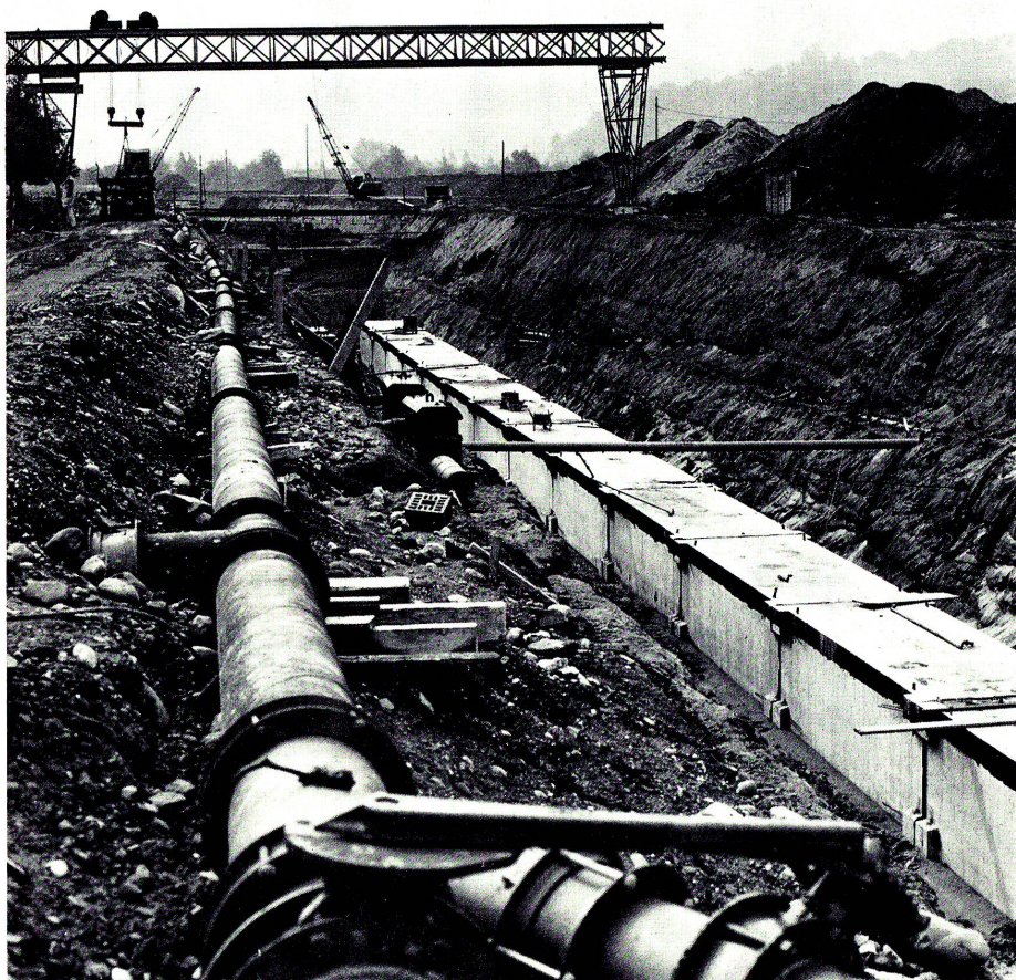
Hauptzulaufkanal Altenrhein. Versetzen der vorfabrizierten 30-to-Kanalelemente. Photo Spannbetonwerk AG, Widnau.
