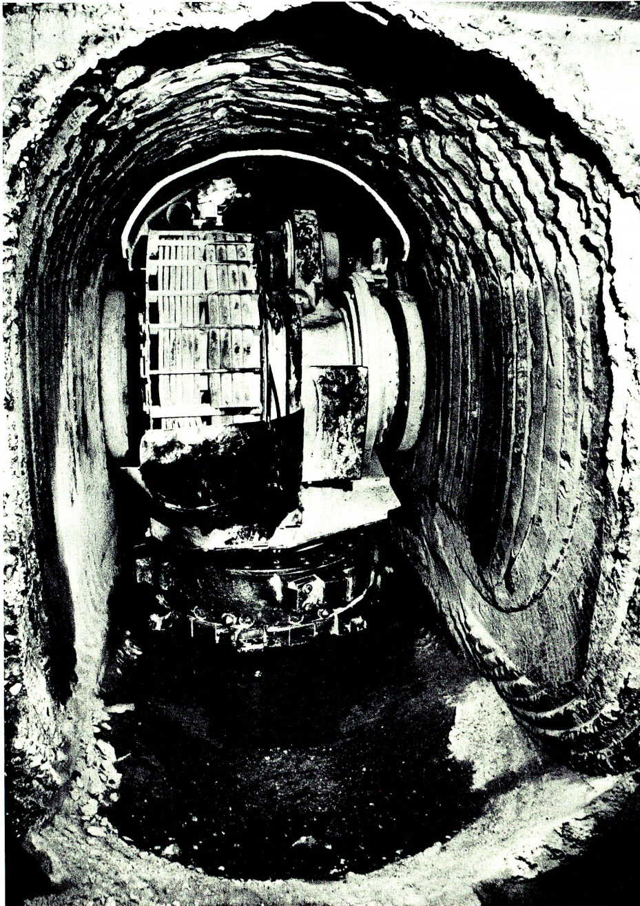
Mini-Stollenfräse nach dem Durchschlag des Querstollens Rorschach-Ost. Photo Grund- und Tiefbau AG, Stäfa.
