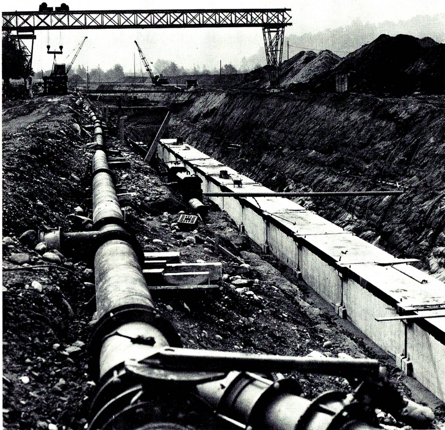
Hauptzulaufkanal Altenrhein. Versetzen der vorgefertigten 30-to-Kanalelemente. Photo Spannbetonwerk AG, Widnau.
