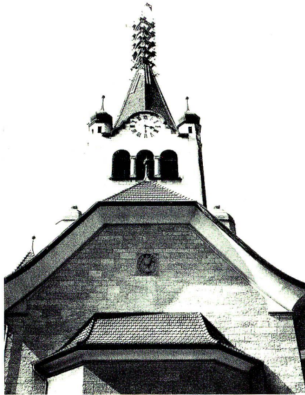
Reparaturarbeiten an der Turmspitze der evangelischen Kirche Rorschach. Foto P. Hug
