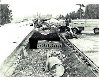
Zügeln eines Schutzdaches nach dem Umsetzen des Betonzuges auf die andere Fahrbahn.
