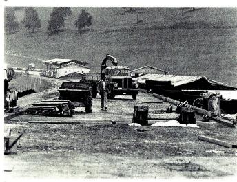
zeit verhindert. Damit der junge Beton vor direkten Witterungseinflüssen geschützt wird, sind alle Einbaumaschinen mit fahrbaren Dächern ausgerüstet. Ebenso wird mindestens ein Drittel einer Tagesetappe von durchschnittlich 300 m mit separaten Dächern geschützt.
