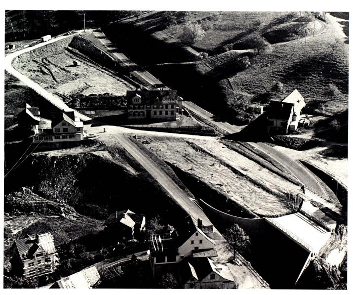
Die Pfeiler des 510 bzw. 450 m langen «Goldachviaduktes» von «Meggenhus» Richtung «Möttelischloß» gesehen. Der Viadukt liegt im Bereich eine Kurve mit Radius 750 m. Im Vordergrund links erkennt man die Betonaufbereitungsanlage, sowie die Baracken für Unterkunft, Büro und Magazine. Foto Walter Baer.
