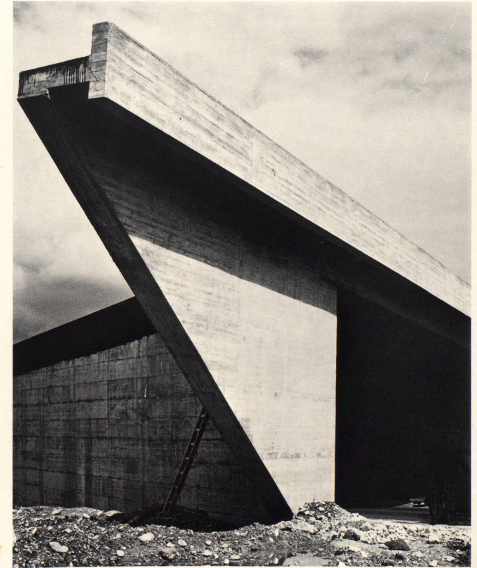
Flügelmauer der Unterführung «Untereggerstraße». Foto F. Krüsi.
