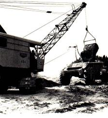
Auf der östlichen Seite des Goldachtobels bis ca. «Guggenbüel» werden die feinkörnigen Seeablagerungen, sowie die stark wasserführenden Hangmoränen durchfahren. Diese Einschnitte bedingen vor und während der Erdbauarbeiten umfangreiche Entwässerungen. Im unteren Teil hingegen liegt der Molassefelsen sehr hoch.
