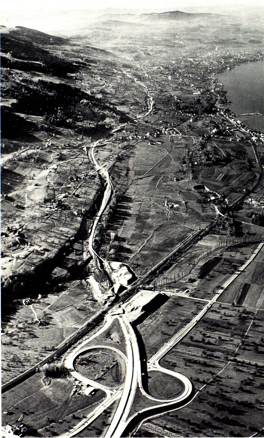
Gesamtübersicht der zukünftigen N1 im Bereich Rorschacherberg. Der Verlauf des Trasses ist durch das Band der Baustraße markiert. Die Deponien des vorsorglich beschafften Kiesmaterials für den Oberbau sind beidseits der SBB-Linie gut erkennbar. Foto Walter Baer.
