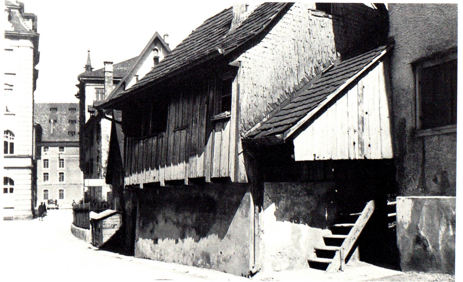
An der Ankergasse, vor dem Abbruch, 1955. Im Hintergrund das Kornhaus Photo H. Labhart
