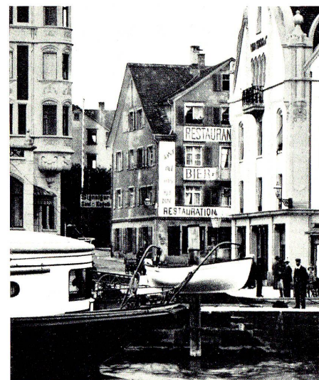
16 Das Signal vor dem Abbruch Photo Labhart
