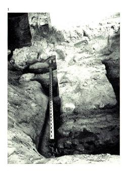
Vor der rechten Chorwand ist auf der älteren (dunkleren) Mauer die jüngere (hellere) aufgesetzt
