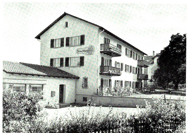
«Zu den Schurtannen», links Ladenanbau
