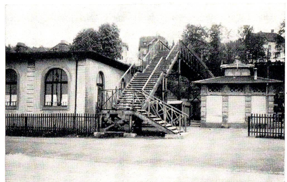
Nord-Süd-Ansicht der Passarelle vor dem Abbruche.
