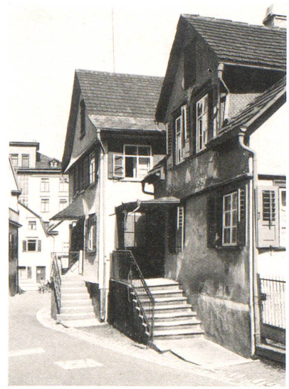
Dem Abbruche verfallen.
