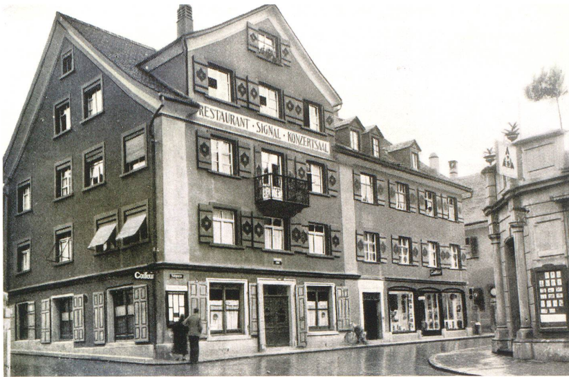
Das «Signal» vor dem Abbruch.
