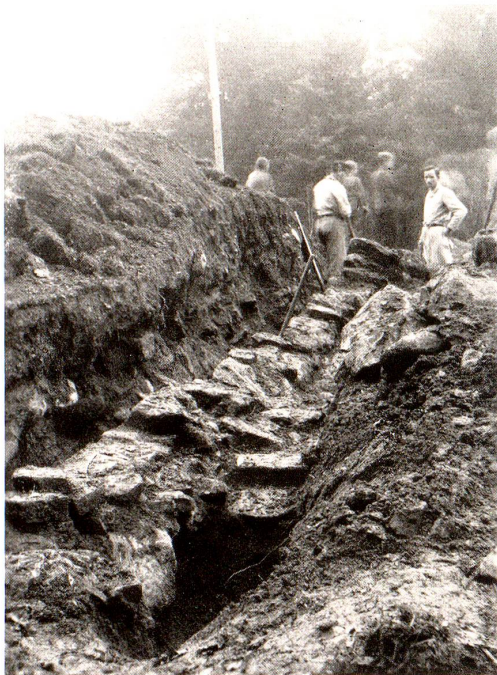
Abb. 2. Trockenmauer auf der Nordseite. Feld II.
