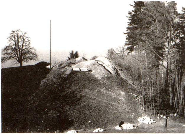
Abb. 1. Ansicht von Süden her. Sondierungsgräben.
