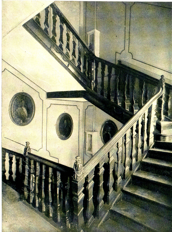
Treppenhaus, Marienbergstrasse No. 17.
