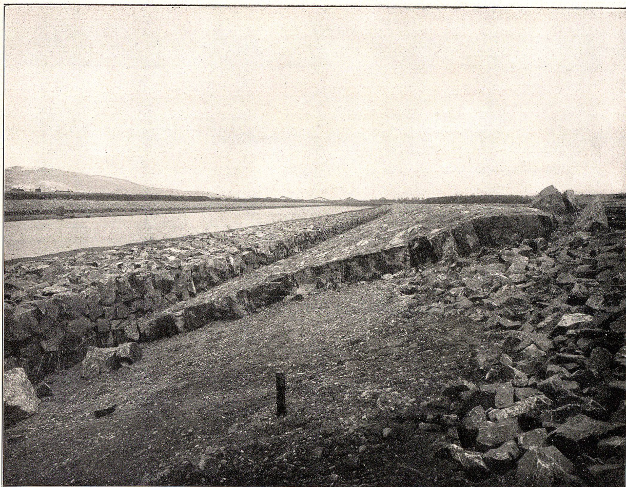
Abbildung 6. Steinbauten am rechtseitigen Ufer, in Ausführung begriffen.
