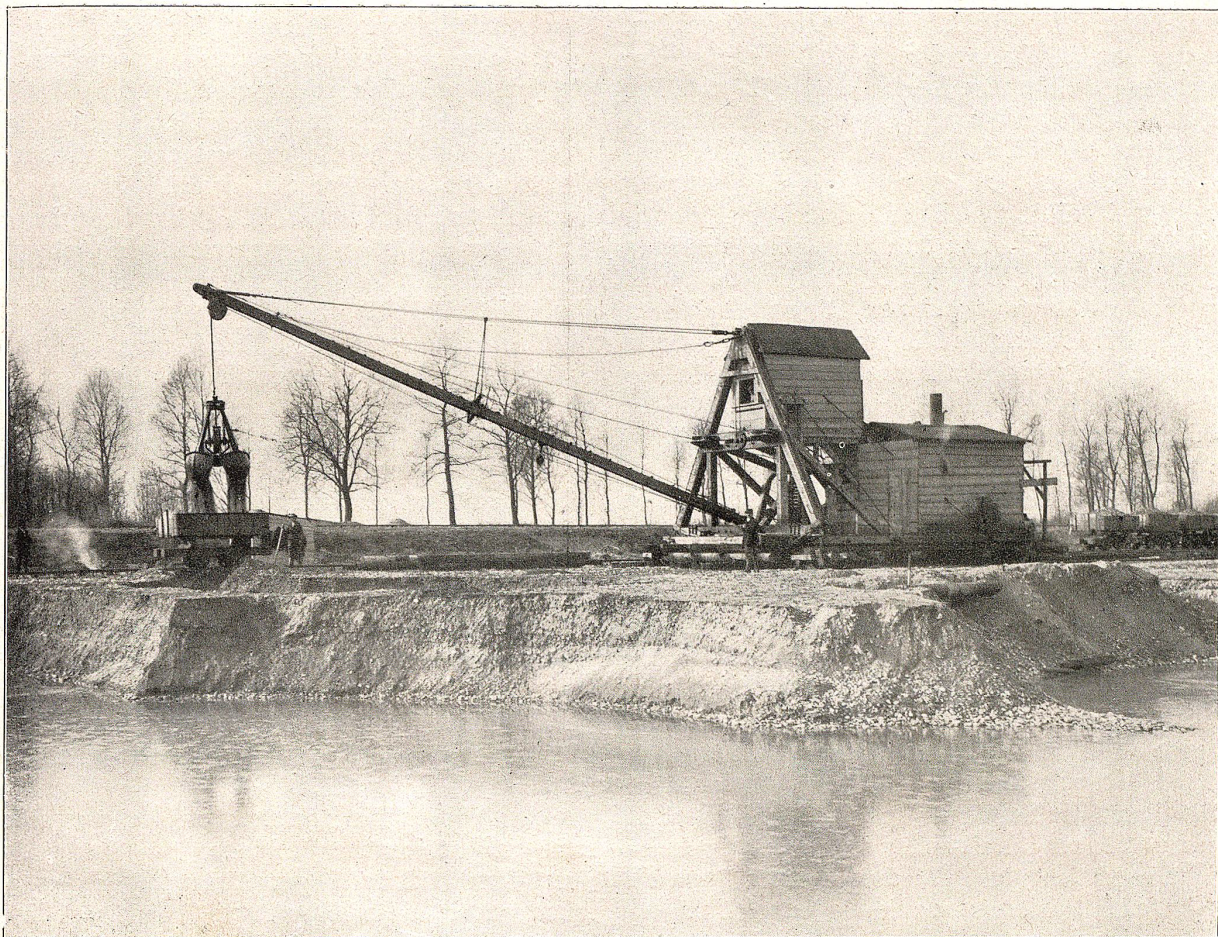
Abbildung 4a. Kiesgewinnung aus dem Rheine mit Greiffbagger zum Herstellen der Dämme und Vorländer des Durchstiches; das Baggergut wird vom Greifer direkt in Rollwagen verladen.
