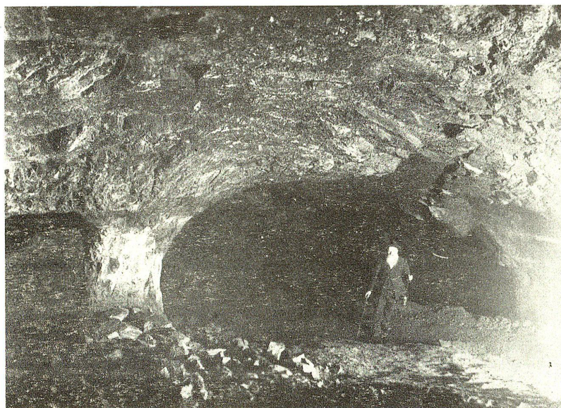
Abbildung 4. Grubenraum in Grube I des alten Bergwerkes. Links einer der säulenförmigen Träger, welche beim Abbau stehen gelassen wurden, um das „Hangende“ oder „Dach“ der Grube, das heisst das Deckgebirge, zu stützen. Der Bergmann bezeichnet diese Träger als Erzhas.
