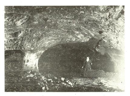
Abbildung 4. Grubenraum in Grube I des alten Bergwerkes. Links einer der säulenförmigen Träger, welche beim Abbau stehen gelassen wurden, um das "Hangende" oder "Dach" der Grube, das heisst das Deckgebirge, zu stützen. Der Bergmann bezeichnet diese Träger als Erzhals.
