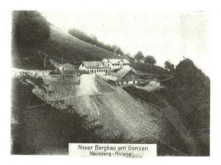
Abbildung 10. Die neuen Anlagen am Nausberg. Das Erzlager wird hier durch einen langen Stollen angefahren, dessen Ausgang oder Mund links neben den Gebäuden sichtbar ist (vergleiche auch Abbildung 11). Im Vordergrunde der von dem Stollenbau herrührende grosse Schuttkegel.
