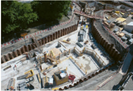
Construction des fondations pour le nouveau bâtiment.
