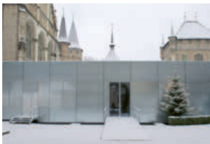
Durant les travaux, les expositions temporaires ont eu lieu dans le pavillon de la cour intérieure.
