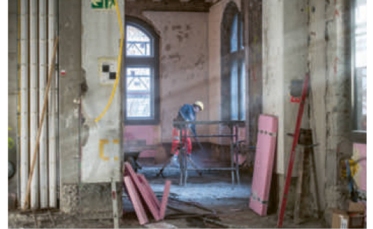
Peu après l'inauguration du nouveau bâtiment, les travaux de rénovation se sont poursuivis pour remettre au goût du jour les pièces historiques de l'aile ouest.
