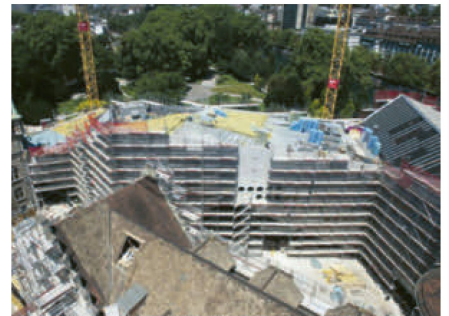
Le nouveau bâtiment après le bouquet final. Le bâtiment a pu être livré à la direction du musée en décembre.
