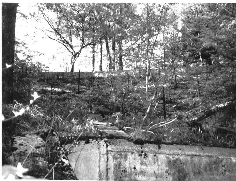
Ouvrage du Gy: la dalle qui recueille l'eau de pluie, pour l'équipage.
