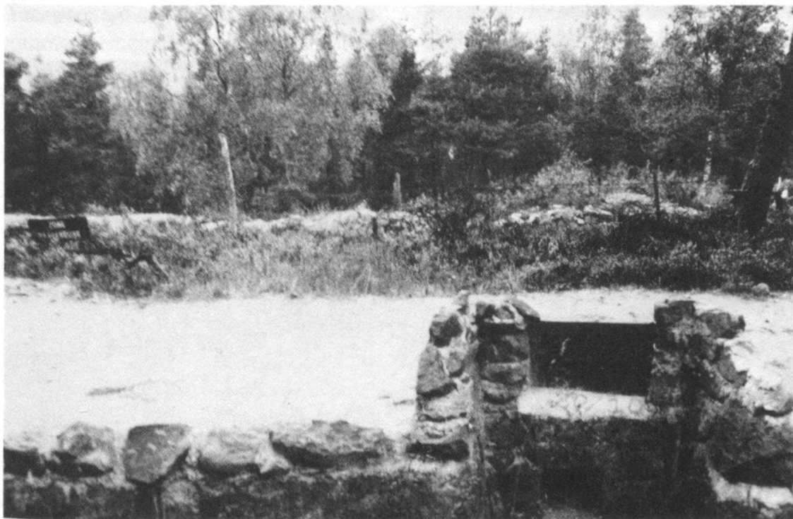
Les soldats français, pour atteindre leur objectif, devaient couvrir plusieurs centaines de mètres dans une pente très inclinée. Ils se trouvèrent bloqués à quelques mètres des tranchées allemandes et se mirent à creuser. On distingue une ligne claire au-delà du sentier. Ce sont les restes de leur tranchée.
