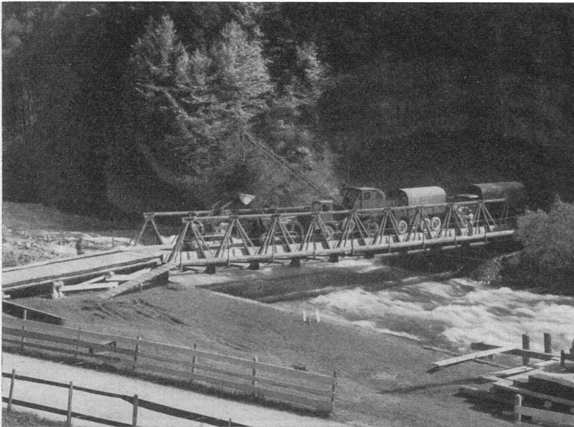
FIG. 7. — Pont lourd d'ordonnance en acier, portée 30 m., essai de charge. (Photo C.-F. Kollbrunner. Cliché Techn. Mitt.)
