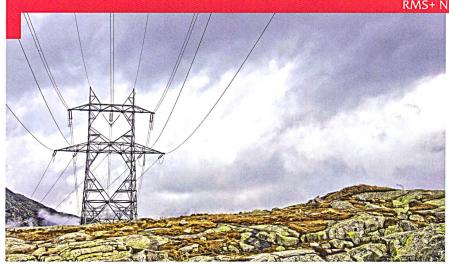
Une ligne à haute tension dans les Alpes. La mise hors service d'une seule de ces lignes peut suffire dans certaines circonstances à provoquer une chute du réseau.
