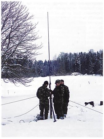
Ci-dessus: Installation d'antennes-relais VHF pour le réseau tactique SF-X35.
