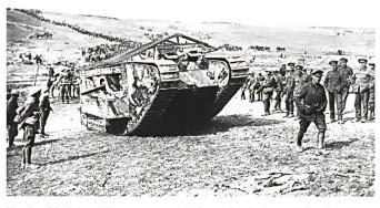
Un char Mark I « mâle » monte vers le front. On distingue, à l'arrière, les roues (ici en position levée) sensée aider aux changements de direction. Cette assemblage sera vite abandonné. La « cage de poules » au-dessus de l'engin a été conçue pour se protéger des jets de grenades à main.
