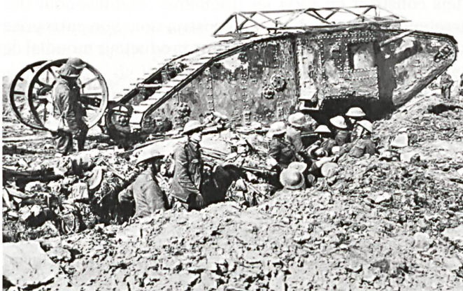
Un char Mark I « mâle » monte vers le front. On distingue, à l'arrière, les roues (ici en position levée) sensée aider aux changements de direction. Cette assemblée sera vite abandonnée. La « cage de poules » au-dessus de l'engin a été conçue pour se protéger des jets de grenades à main.
