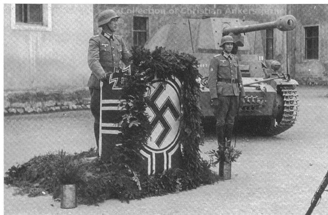
Le Marder III est réalisé à partir du châssis tchèque 38 modifié. Il est mieux protégé et plus facile à camoufler.
