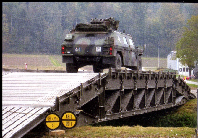
Le pont fixe 69 est lent à mettre en œuvre et nécessite une main d'œuvre importante ; sa longueur peut aller jusqu'à 48 mètres. En raison de son âge, le pont fixe 69 n'est utilisé aujourd'hui qu'avec de nombreuses servitudes : 29,33 mètres et 28 tonnes de charge au maximum.
