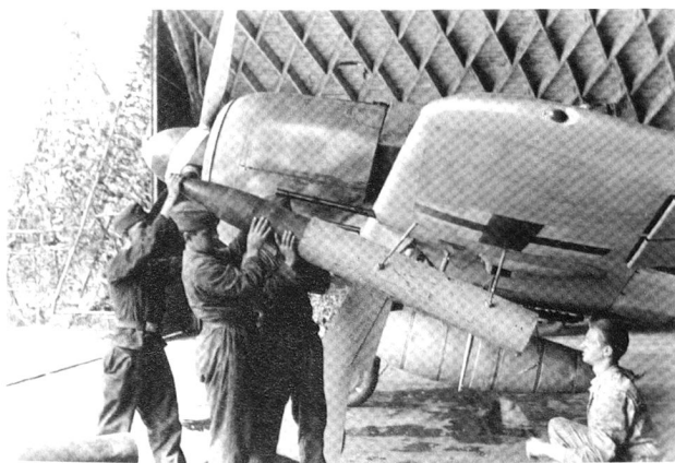
Chargement de fusées de 21 cm air-air sous un FW-190.
