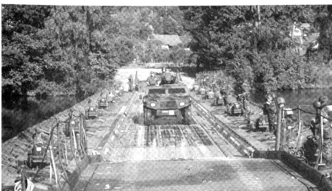
Pont flottant à Widegg.
