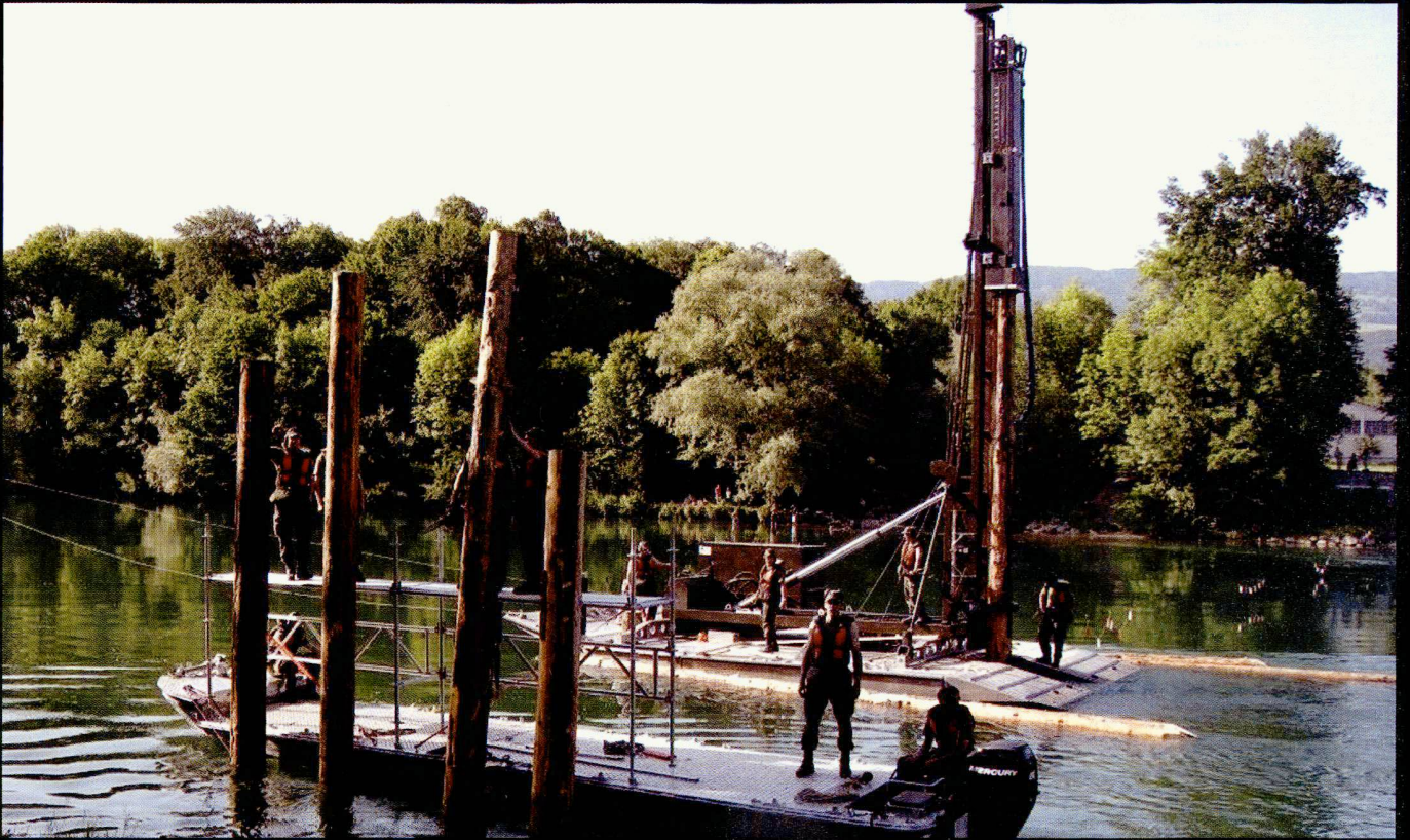
Construction d'un pont au moyen d'une sonnette. Photo © bat G 2.
