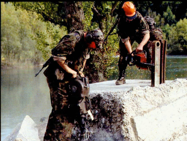
Les sapeurs peuvent être engagés sur des chantiers pour déblayer ou construire des obstacles en tous genres.
