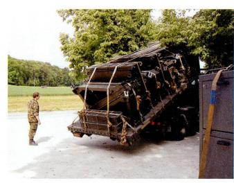
Les étapes de la construction du pont fixe 69. Les éléments du pont sont déchargés des camions.
